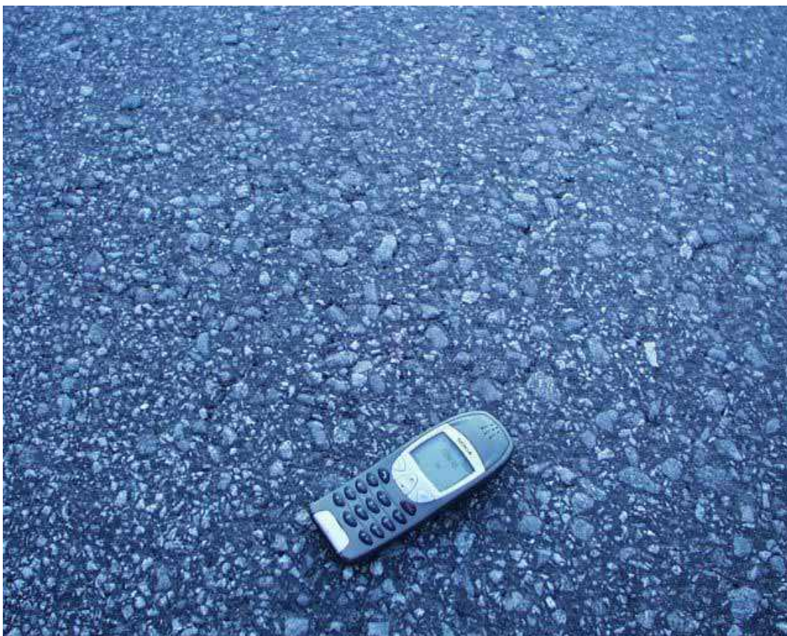
Kuva 55. SMA 8 -päällyste näytti Kokkolan koetiellä pahimmillaan tältä
