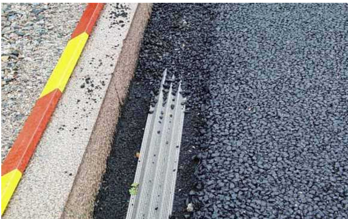
Kuva 12. Salaojitus Meripellontiellä
