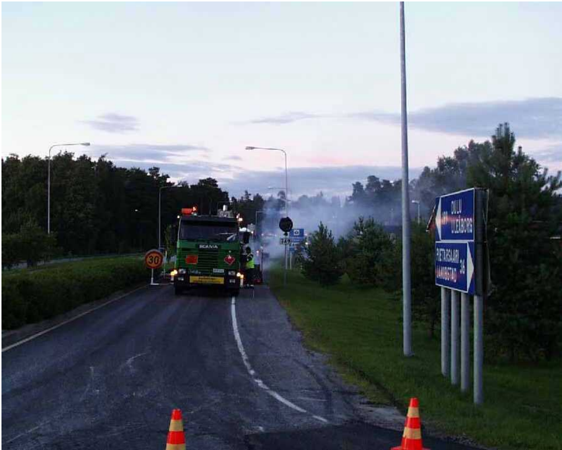
Kuva 19. Kokkolan koeteiden rakentamista (REM+)
