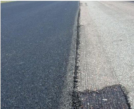
Koneellisesti tiivistetty ja viistottu päällysteen reuna. Oikealla lähikuva.
