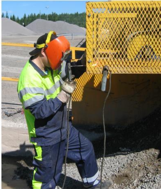
Kuva 5 Osa asfalttiasemien tulitöistä tapahtuu ulkotiloissa.
