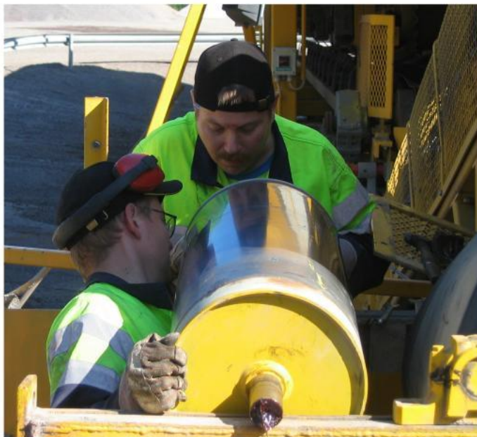
Kuva 3 Hihnakuuljettimen laakerinvaihto kesken työpäivän
