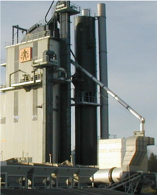
Kiinteän asfaltiaseman täytejauhe ja kivipölysilot
