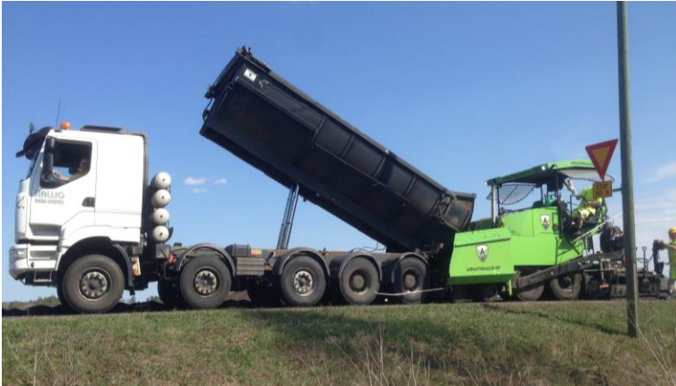
Massankuljetusauto purkaa massaa levittimeen. Korotuskulma ja peräylitys mahdollistavat purkamisen
