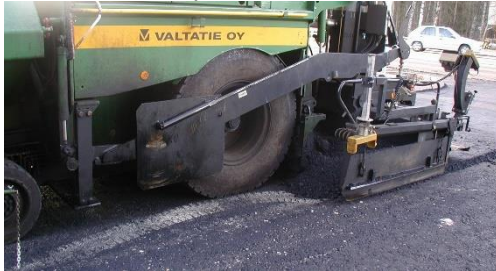
Kuva 10 Nivelpisteen korkeuden säätö
