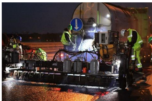
Valuasfaltin koneellista levitystä ja kuljetuskein
