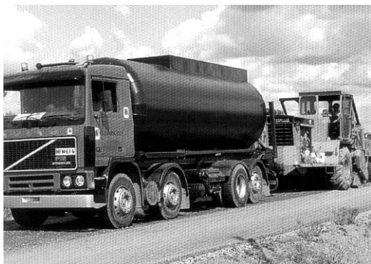
Sideaineen syöttöä stabilointikoneeseen
