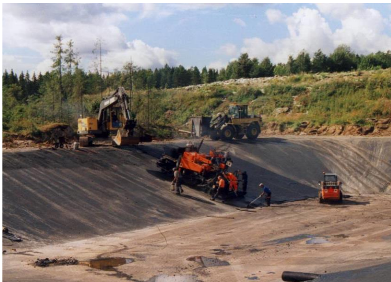
Kaatopaikka-alueen päällystäminen asfaltilla
