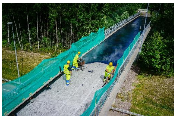
Kuva 7 ja 8 Valuasfaltti levitetään pienissä ja/tai hankalissa kohteissa yleensä käsityönä käsityökaluilla ja muissa kohteissa koneellisesti.
