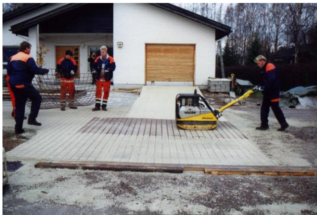
Valkoinen asfaltti, johon muottiverkon avulla tehdään noppakivimäinen kuviointi
