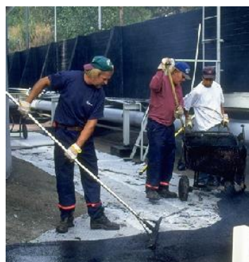
Kuva 7 ja 8 Valuasfaltti levitetään pienissä ja/tai hankalissa kohteissa yleensä käsityönä käsityökaluilla ja muissa kohteissa koneellisesti.
