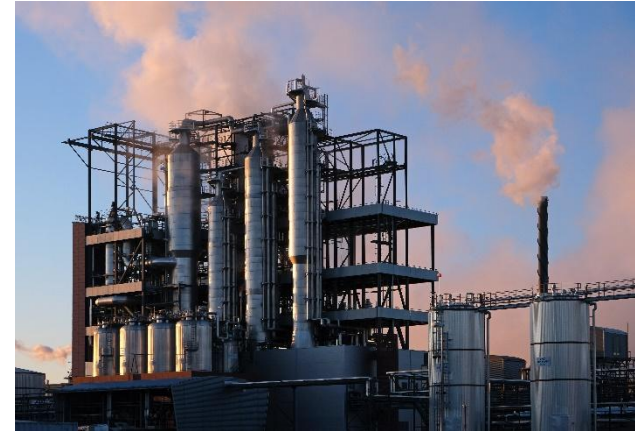
Kuva 2: Forchemin mäntyöljytislaamo Raumalla. Wikipedia CC BY-SA 4.0
